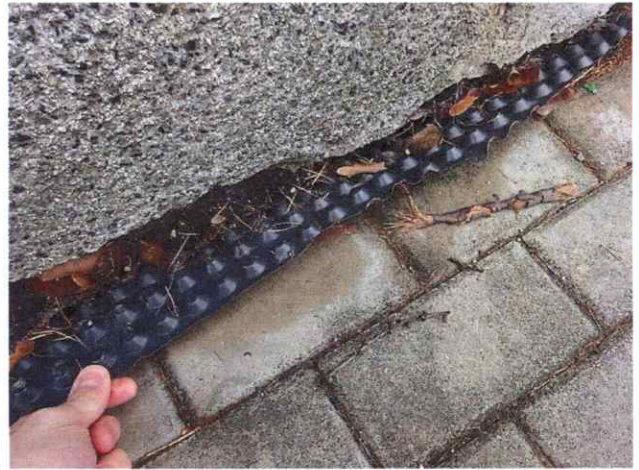
foto /16/ Ukončení nopové fólie u objektu
