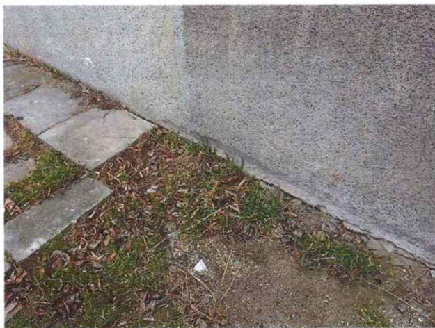
foto /17/ Přiléhající terén ve dvorní části
