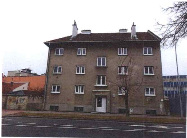
foto /1/ Pohled z ulice
