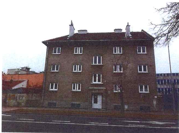
foto /1/ Pohled z ulice
