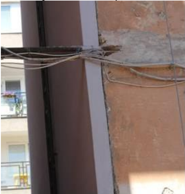
foto /24/ Napojení kontaktního zateplovacího systému na omítnutou stěnu bez zateplení.
