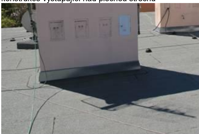
foto /5/ Nápojení hydroizolace střechy na související konstrukce provedeno plechovým lemováním
