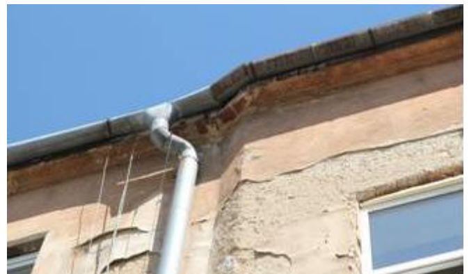
foto /12/ Chybně provedenými okapovými žlaby zatéká dešťová voda na atiku, která degraduje.
