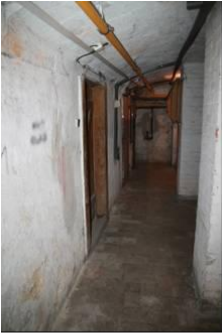
foto /57/ Dlouhé nezateplené rozvody vody – původní olověné rozvody do bytů. Po rekonstrukci pouze ležaté rozvody v suterénu.
