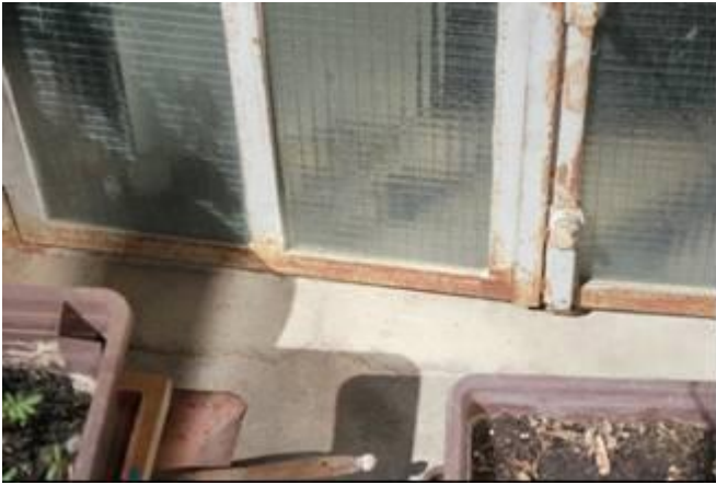
foto /27/ Parapet sklepního okna na úrovni terénu
