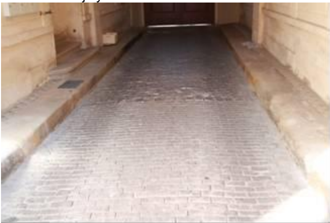
foto /33/ Deformace dřevěné dlažby v průjezdu vlivem nadměrného zatížení podloží (zřejmě od vozidel)
