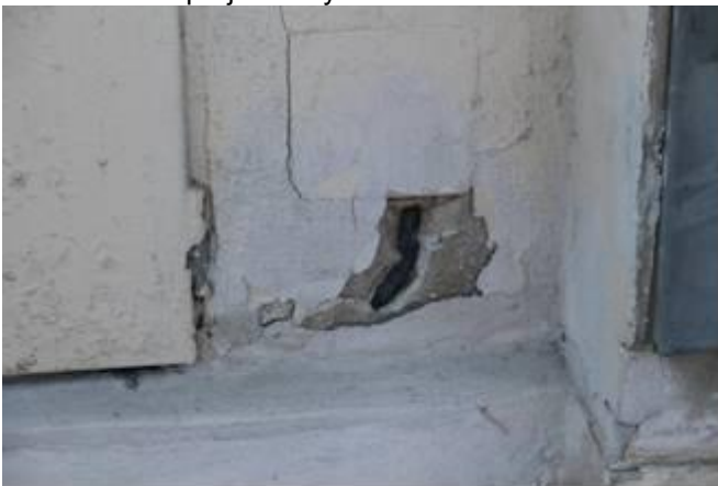
foto /56/ Obnažený kabel mezi rozvodnou skříní a hlavními domovními jističi.
