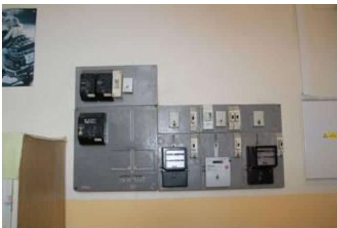
foto /51/ Podružné jističe a elektroměry nejsou umístěny v rozvodné skříni, nejsou dostatečně zabezpečeny proti poškození a úrazu el. proudem. Jednotlivé jističe nejsou popsány.
