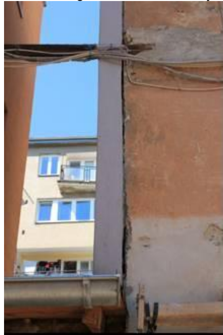
foto /24/ Napojení kontaktního zateplovacího systému na omítnutou stěnu bez zateplení.
