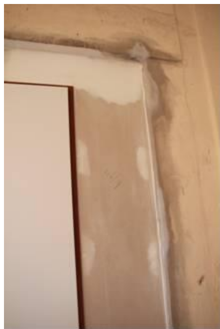
foto /34/ Změna výplně otvorů – původní vrata nahrazena materiálově odlišným řešením (SDK) – kromě neestetického provedení může docházet k prasklinám na rozhraní materiálů
