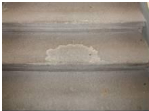
foto /45/ Poškozená pískovcová podlaha v prostorech s intenzivním provozem (schodiště), poškození odpovídá stáří objektu a běžnému opotřebení s absencí údržby.
