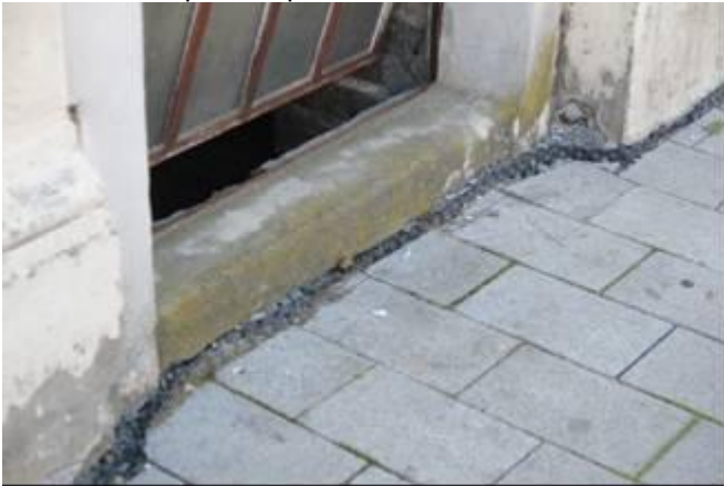
foto /29/ Zásyp na uliční straně domu s nopovou folií
