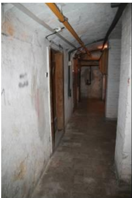
foto /59/ Dlouhé nezateplené rozvody vody – původní olověné rozvody do bytů. Po rekonstrukci pouze ležaté rozvody v suterénu.
