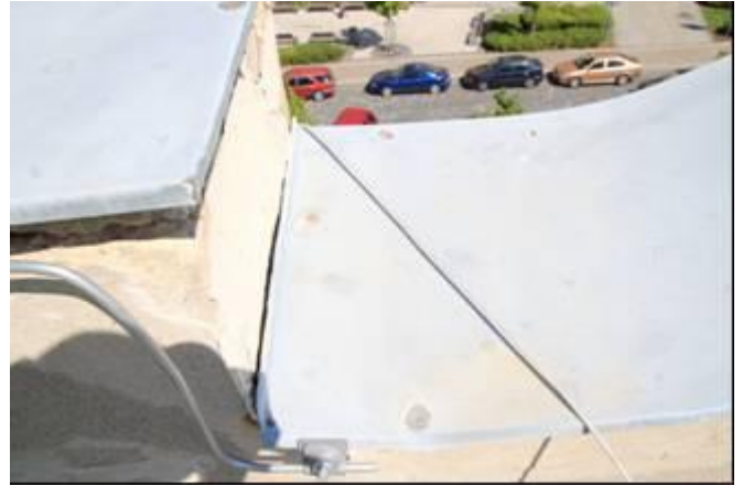
foto /8/ Netěsnosti mezi krycí (oplechování) a stavební konstrukcí.
