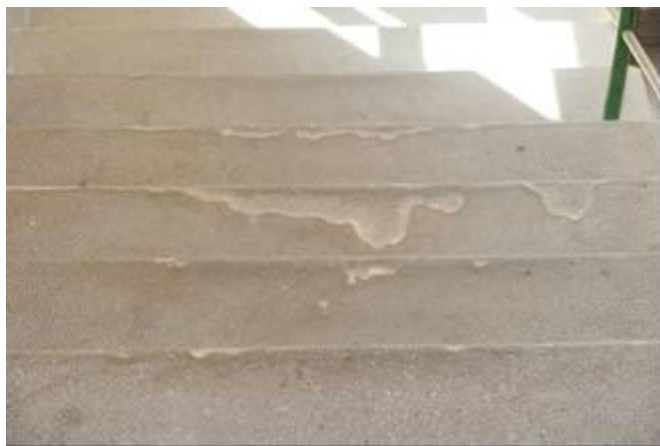
foto /45/ Poškozená pískovcová podlaha v prostorech s intenzivním provozem (schodiště), poškození odpovídá stáří objektu a běžnému opotřebení s absencí údržby.
