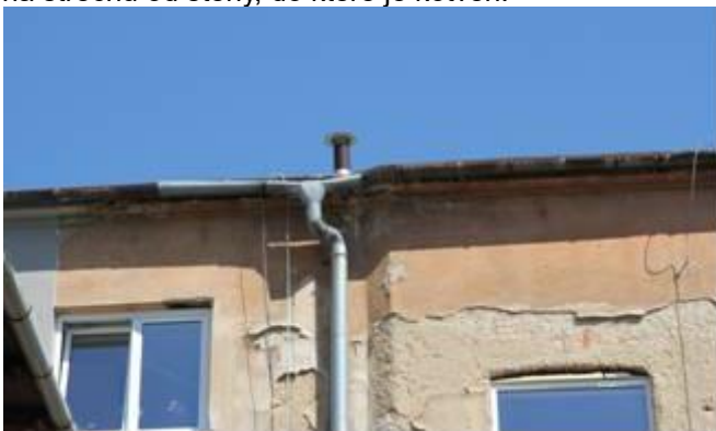
foto /12/ Chybně provedenými okapovými žlaby zatéká dešťová voda na atiku, která degraduje.
