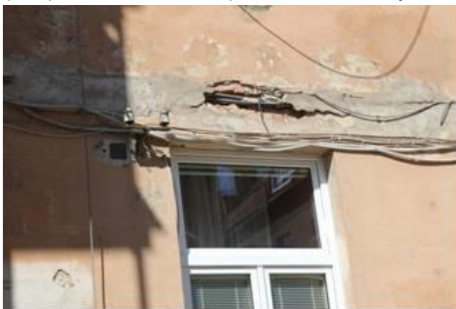
foto /52/ Elektroinstalace je v původním stavu. Uložení elektro rozvodů v průjezdu a na fasádě domu a způsob kotvení je nevyhovující. Napojení vedlejšího domu z rozvaděče umístěného v průjezdu bytového domu.
