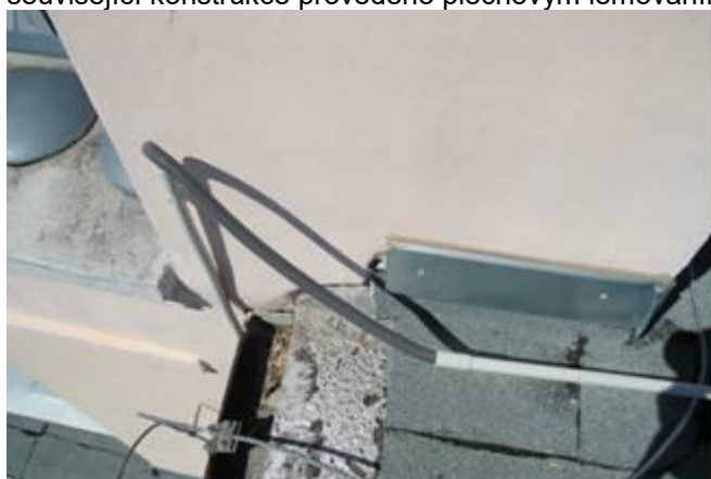
foto /4/ Asfaltové pásy napojeny na plechové lemování v úrovni hydroizolace,
