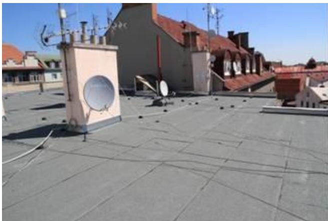
foto /1/ Pohled na plochou pultovou střechu v nejvyšší výškové úrovni
