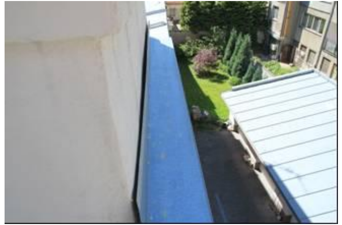
foto /8/ Netěsnosti mezi krycí (oplechování) a stavební konstrukcí.
