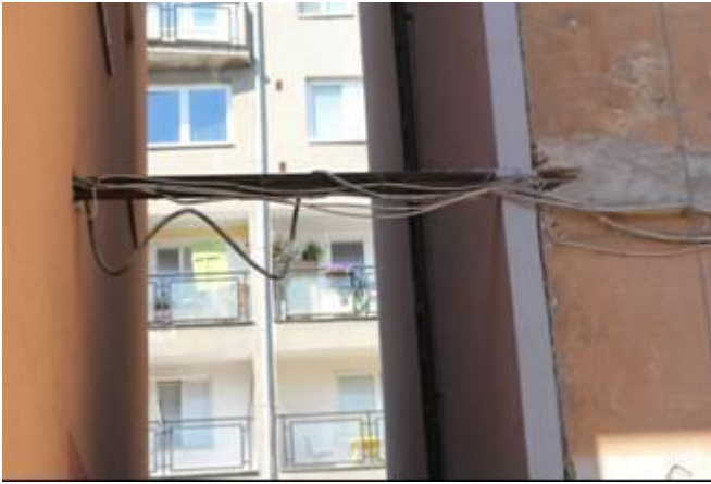
foto /53/ Uložení elektro rozvodů v průjezdu a na fasádě domu a způsob kotvení je nevyhovující. Napojení vedlejšího domu z rozvaděče umístěného v průjezdu bytového domu.
