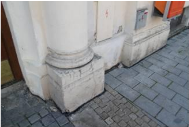
foto /38/ Trhliny v konstrukcích domu od vysychání nebo smáčení hornin
