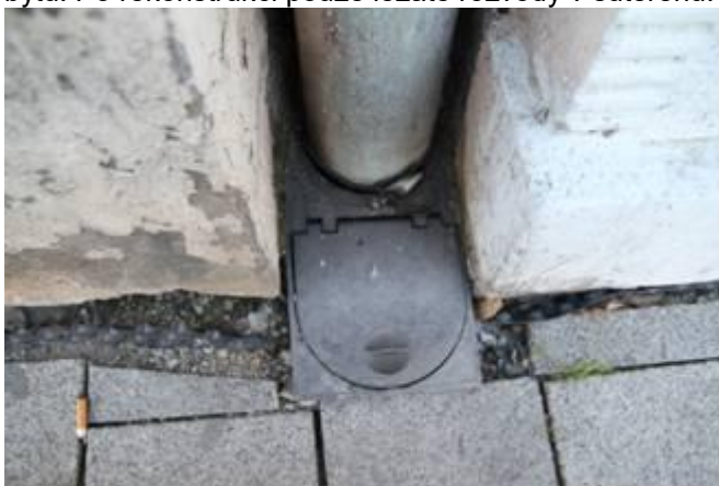
foto /61/ Nečištěný gajgr v uliční části domu
