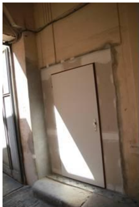
foto /34/ Změna výplně otvorů – původní vrata nahrazena materiálově odlišným řešením (SDK) – kromě neestetického provedení může docházet k prasklinám na rozhraní materiálů
