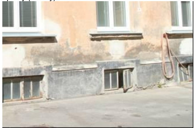
foto /38/ Trhliny v konstrukcích domu od vysychání nebo smáčení hornin
