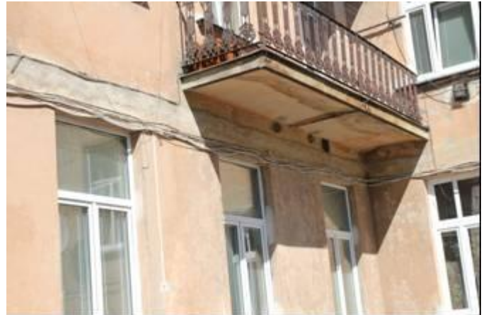
foto /53/ Uložení elektro rozvodů v průjezdu a na fasádě domu a způsob kotvení je nevyhovující. Napojení vedlejšího domu z rozvaděče umístěného v průjezdu bytového domu.
