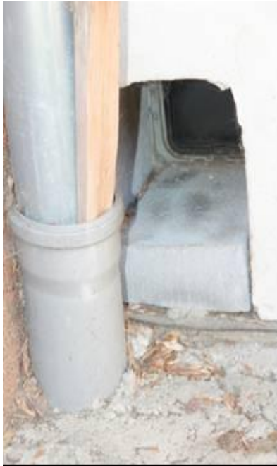
foto /62/ Nově zhotovený svod dešťové vody při střeše u vstupu do bytu ve dvorním traktu včetně nedostatečného přístupu k uzávěru vody
