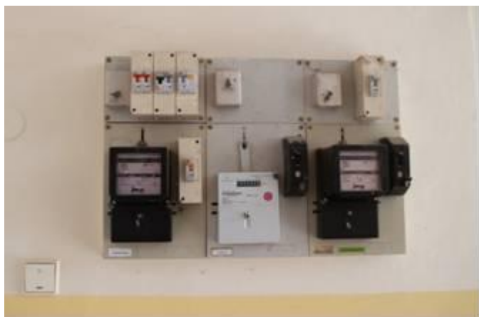
foto /51/ Podružné jističe a elektroměry nejsou umístěny v rozvodné skříni, nejsou dostatečně zabezpečeny proti poškození a úrazu el. proudem. Jednotlivé jističe nejsou popsány.
