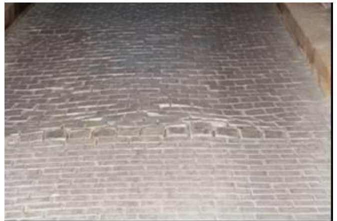
foto /33/ Deformace dřevěné dlažby v průjezdu vlivem nadměrného zatížení podloží (zřejmě od vozidel)
