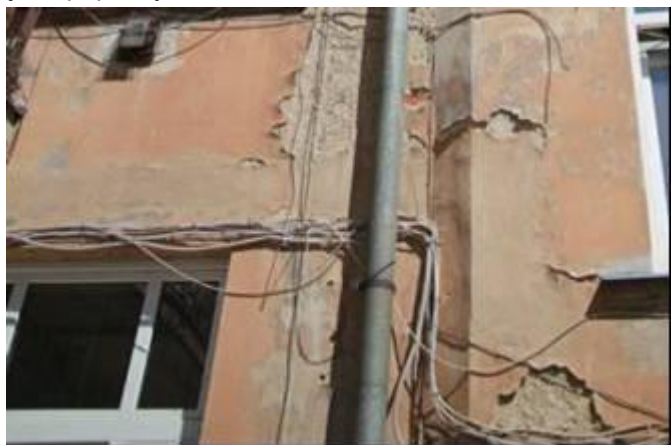
foto /52/ Elektroinstalace je v původním stavu. Uložení elektro rozvodů v průjezdu a na fasádě domu a způsob kotvení je nevyhovující. Napojení vedlejšího domu z rozvaděče umístěného v průjezdu bytového domu.
