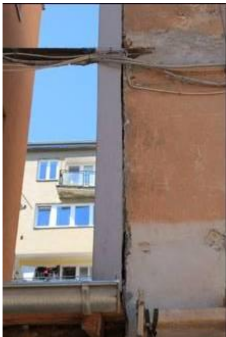
foto /39/ Napojení kontaktního zateplovacího systému na omítnutou stěnu bez zateplení.
