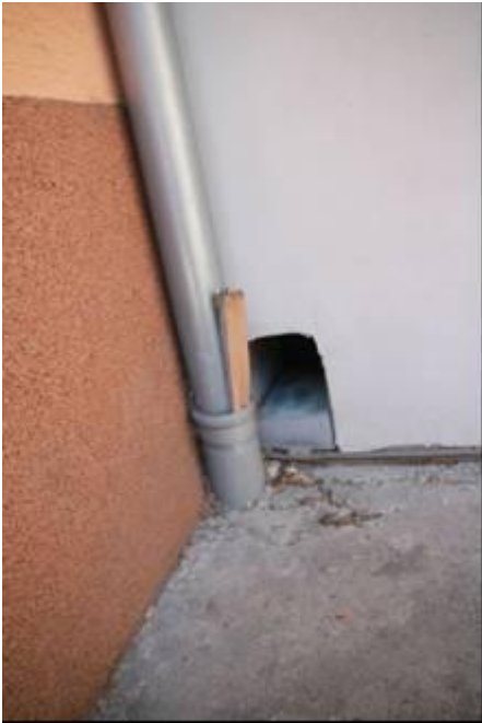
foto /62/ Nově zhotovený svod dešťové vody při střeše u vstupu do bytu ve dvorním traktu včetně nedostatečného přístupu k uzávěru vody
