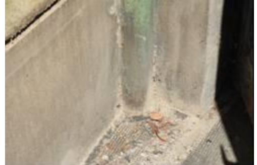
foto /63/ Původní kanalizační svody bez gajgru a bez možnosti čištění a revize
